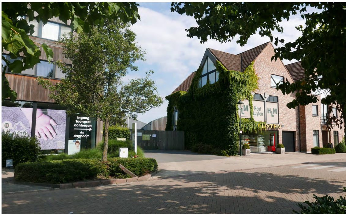
In Morkhoven is een houthandel verweven in het centrum van de kern
